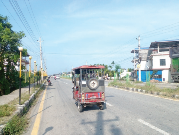
कोसी प्रदेश सरकारअन्तर्गत निर्माण भइरहेको घिनानाघाट-विराटचोक सडक। तस्विर : नागरिक
