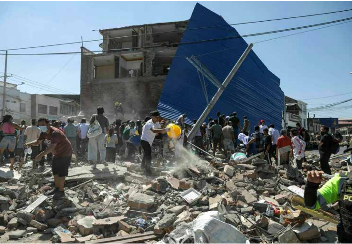
Kurz nach dem Beben: Menschen suchen in den Trümmern eines eingestürzten Gebäudes in Cali nach Überlebenden Foto: Samir Rojas/Getty
