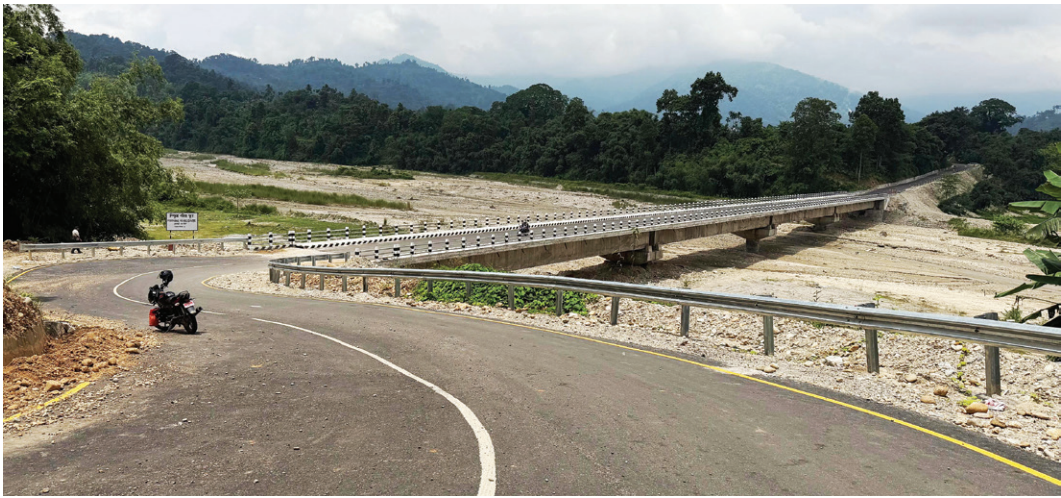
इलामको माई नगरपालिका- ६ स्थित आत्मानन्द मार्गमा रहेको रिखुवा खोला पुल । पुल निर्माण र सडक कालोपत्रपछि महामाई, माइसेबुङ, फाकफोकथुमका बासिन्दालाई आउजाउ गर्न सहज भएको छ ।
