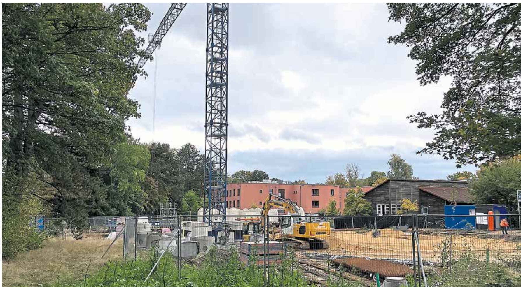
Mittlerweile ist die Baustelle weiter fortgeschritten, fertig soll das Casa Luna 2027 werden Foto: Kaija Kutter
