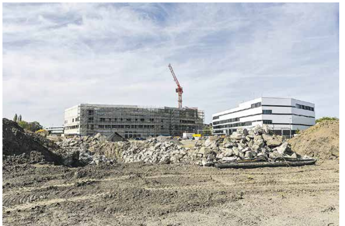
Strukturwandel zum Zweiten: Die Baustelle fürs Industriegebiet Mark 51°7 Foto: Markus Matzel/imagio
