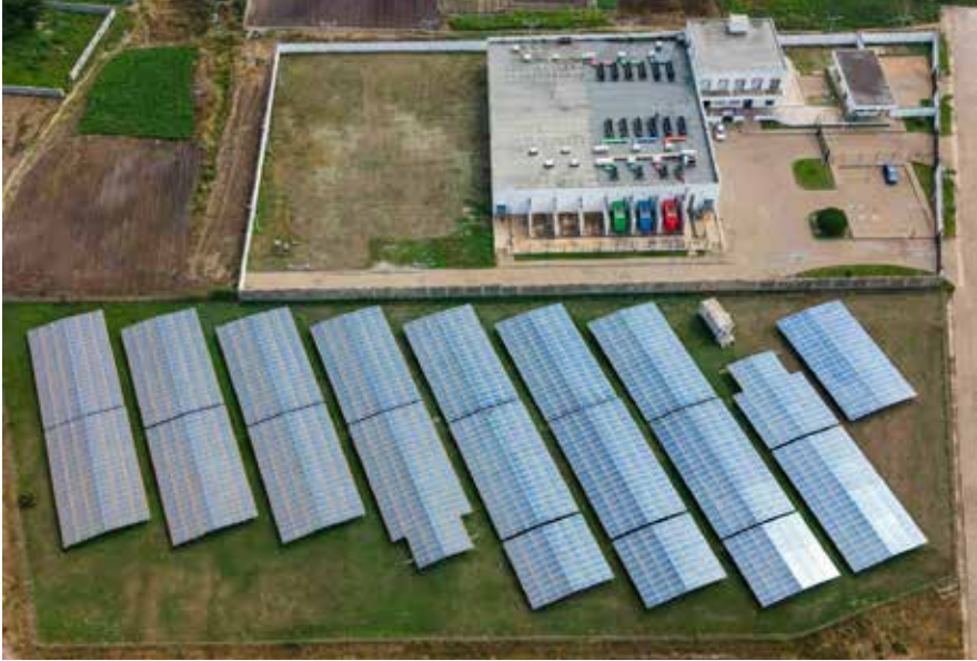
Im Aufbau: Nur rund 250 Rechenzentren gibt es auf dem afrikanischen Kontinent. Das hier steht in Ghana Foto: amazing aerial agency/picture alliance
