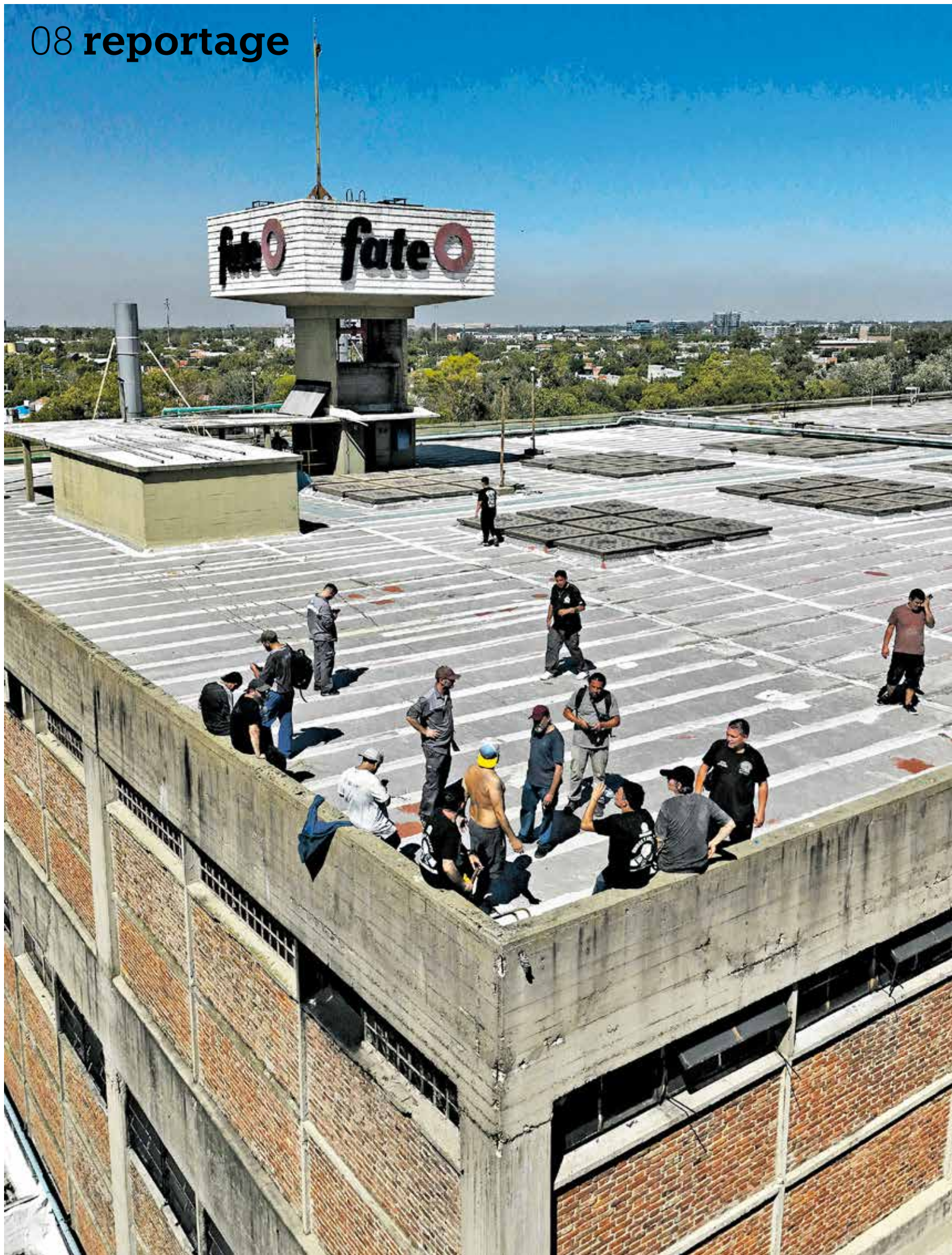
Fate-Arbeiter stehen Ende Februar auf dem Dach der Fabrik Foto: Matias Baglietto/ZUMA Press/imago
