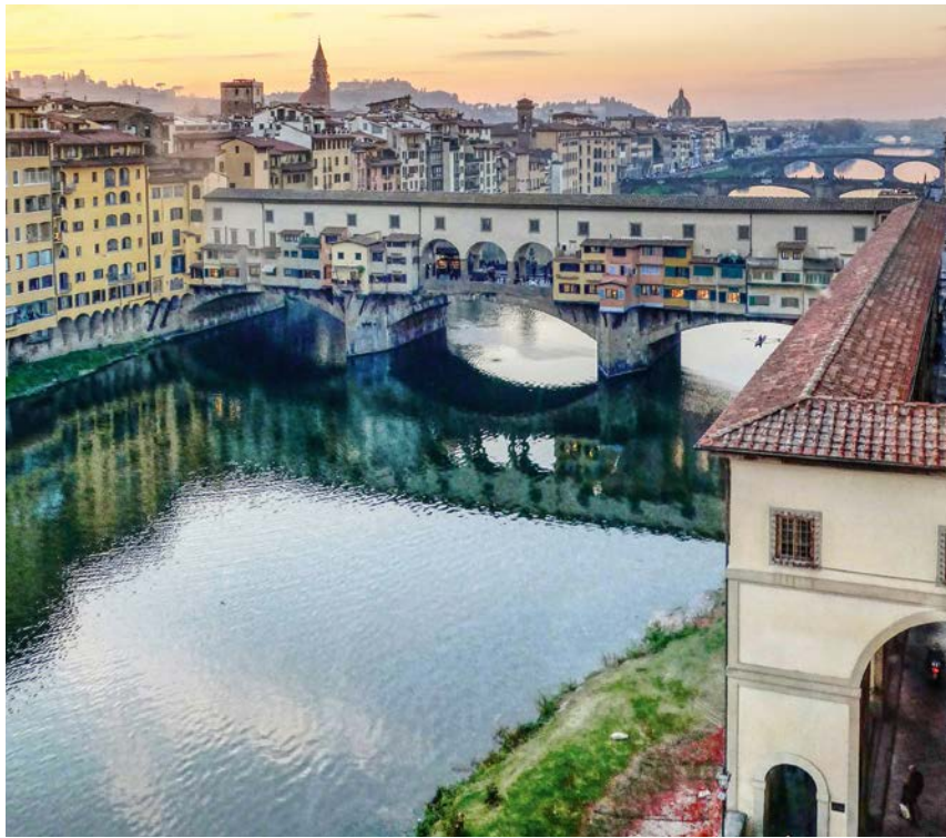
Qui: il tratto di Arno che passa sotto Ponte Vecchio; il caffè storico Le Giubbe Rosse .
